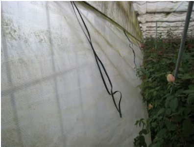
冷気によるカーテンの膨らみ
