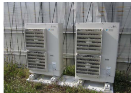
風向ガイドを取り付けた室外機
