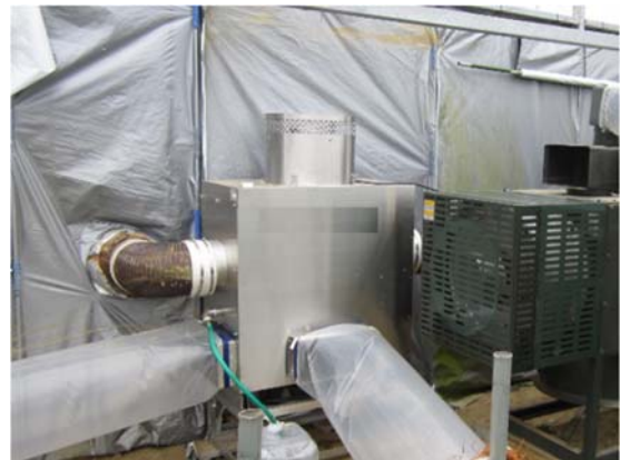
排熱回収装置
