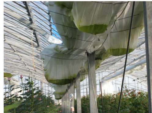
金魚鉢状に膨らんだ内張カーテン
