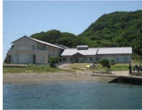
由良交流センター（エトワール生石）
