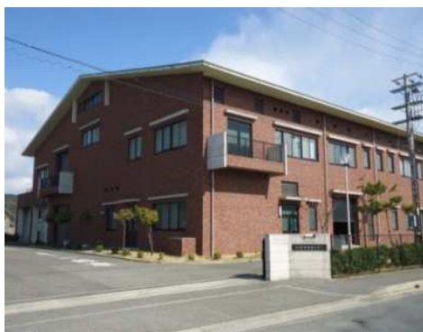
塩屋衛生センターせいすい苑
