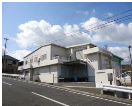
五色給食センター
