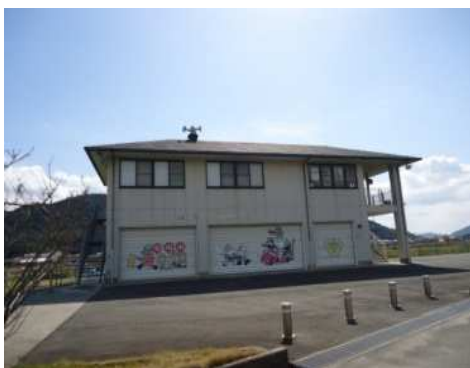
加茂コミュニティ消防センター
