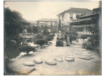
園池東側より西側を望む （第3期）
