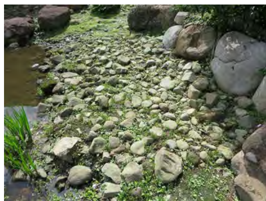
写真Ⅳ - 14 (石・石組) 玉石敷洲浜
