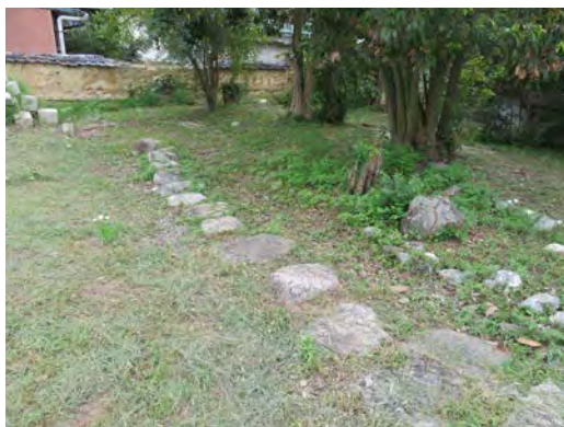
写真IV-42 飛石の不陸・下草の繁茂
