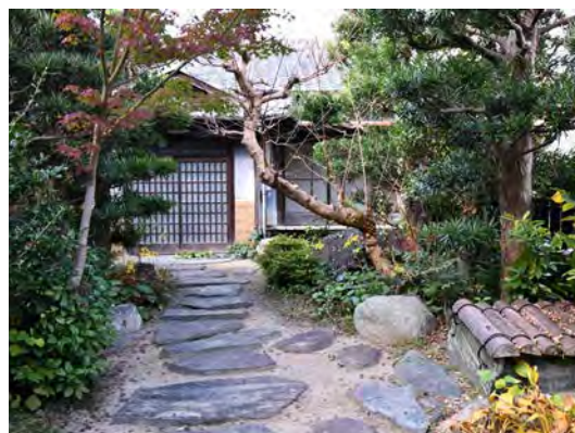
写真IV - 35 (建造物) 新玄関棟
