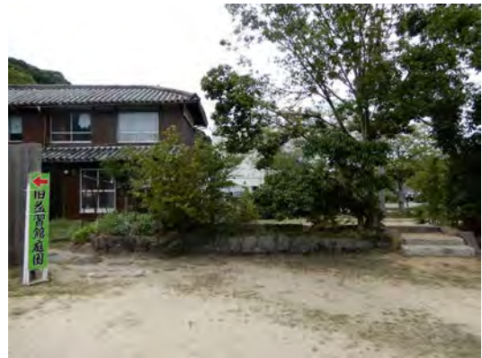
写真IV-5 (構造物) 土塀基礎
