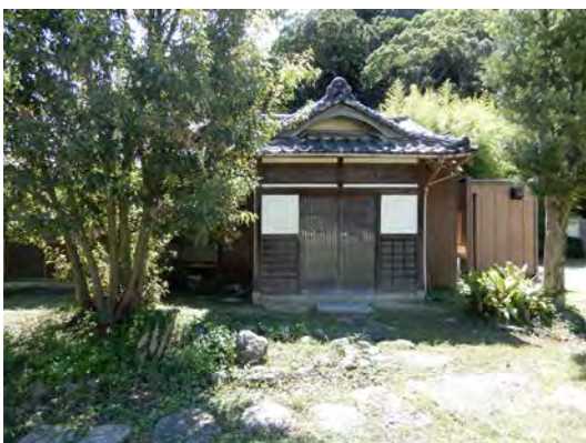
写真IV-6 (建造物) 玄関棟
