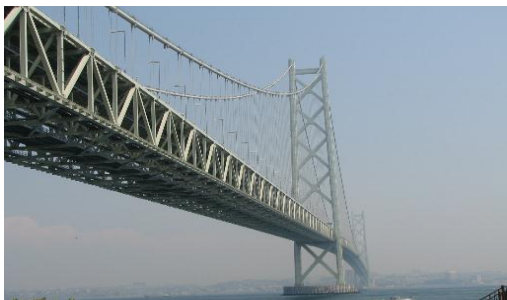
(明石海峡大橋)
