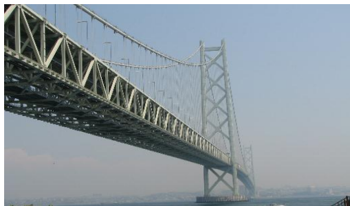
(明石海峡大橋)
