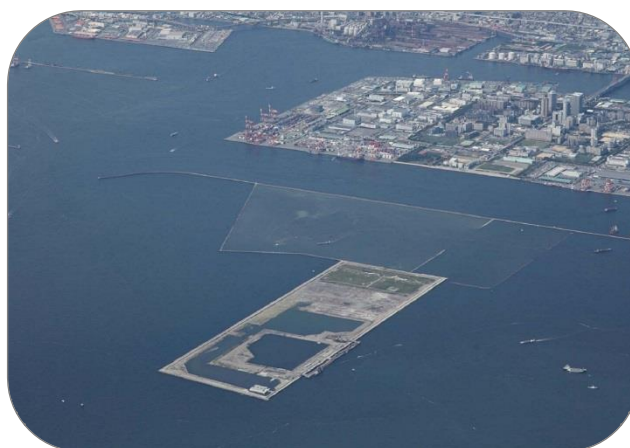
大阪湾広域臨海環境整備センター（神戸沖処分場）
