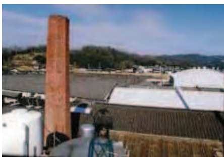
【日本綿布 織布工場】 （岡山県井原市）
