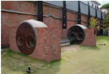
【旧中林綿布工場（ランカシャーボイラー）】 （大阪府泉南郡熊取町）
