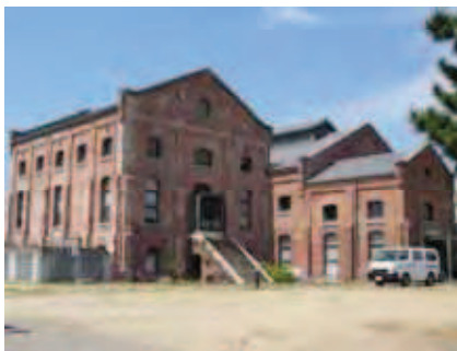
【旧鐘紡洲本工場第3工場汽缶室（淡路ごちそう館「御食国」）】 （兵庫県洲本市）
