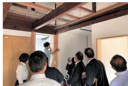
▲改修中の交流拠点
