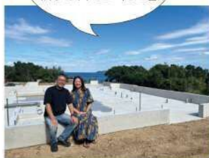
こちらの写真は2023年の夏、建設途中の時のものです。
