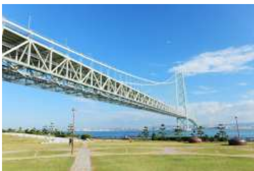
(明石海峡大橋)
