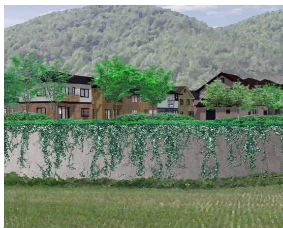
擁壁の緑化修景例
