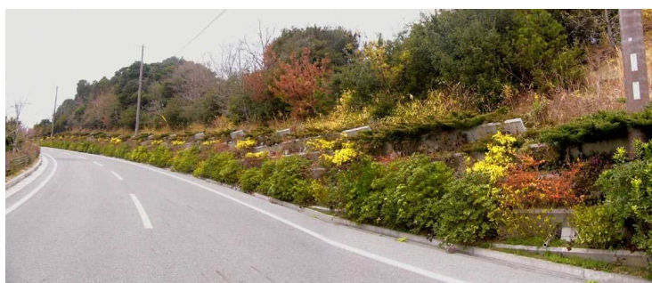
擁壁等への修景緑化例
