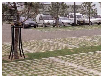
駐車部分の緑化舗装
