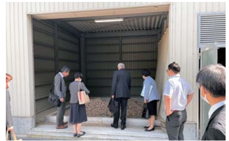
▲竹チップボイラーの見学（名取市）
