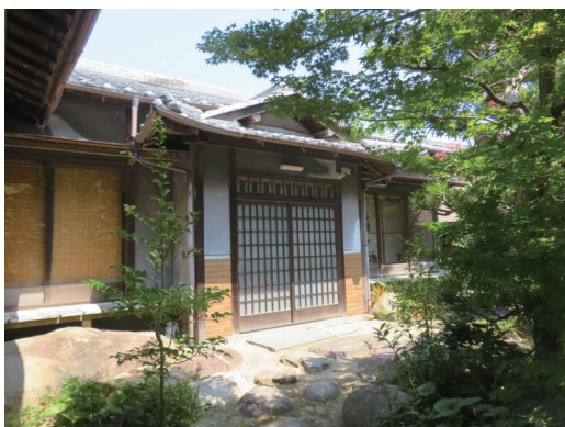
写真IV-3 書院建築 新玄関棟南面
