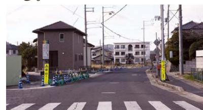
▲工事中の市道加茂中央線道路改良事業
