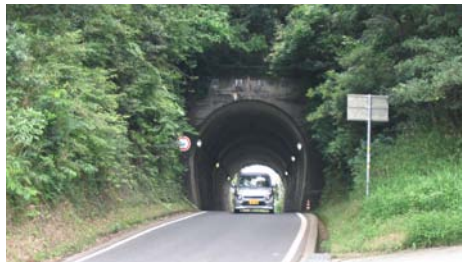
花立トンネル
