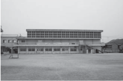
洲本第三小学校屋内運動場
