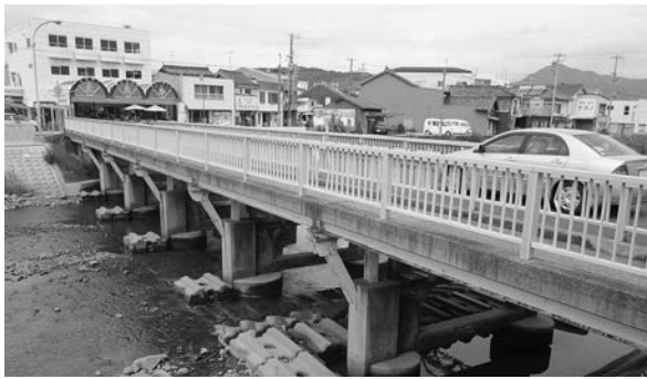
▲長寿命化のため修繕される物部橋
