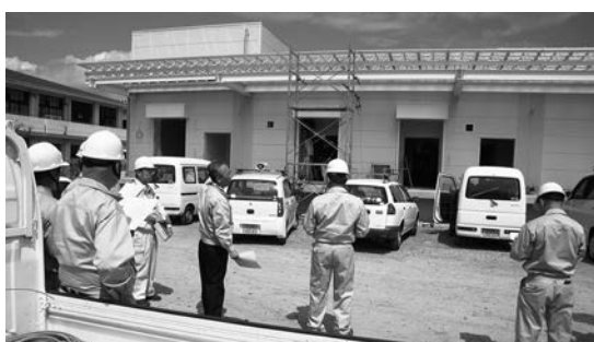
▲建築が進む（仮称）洲本給食センターを調査
