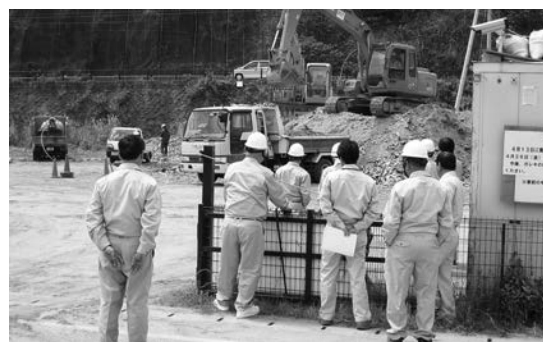
▲炬口に設置されたガレキの仮置き場
