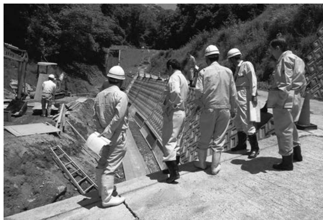
▲農道の復旧工事現場を調査（上内膳）
