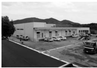
▲急ピッチで建築が進む(仮称)洲本給食センター
