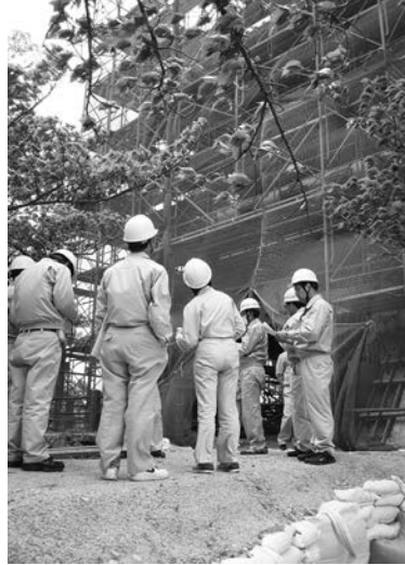
▲洲本城天守閣展望台の修繕工事を調査
