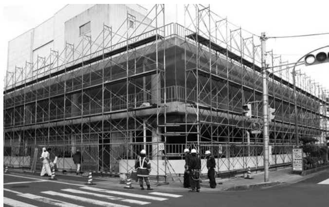
▲新庁舎建設に向け北庁舎の解体撤去工事に着手
