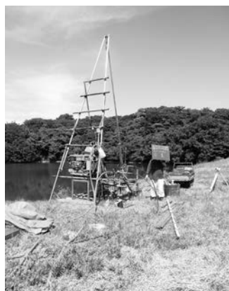
▲耐震診断のボーリング調査を実施（上物部地区の皿池）
