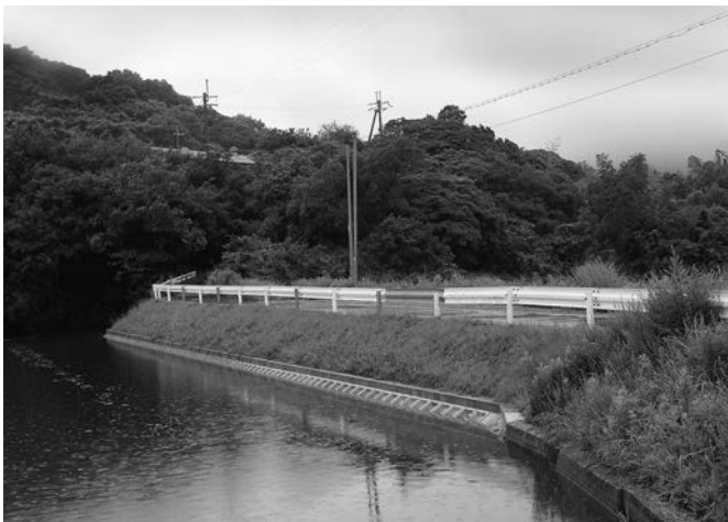
▲復旧工事が完了した鮎原中邑地区の平田池
