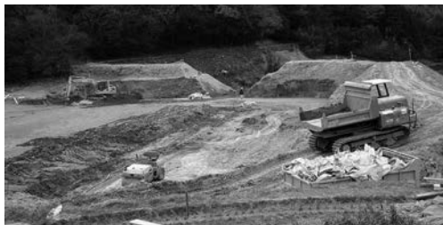
▲鮎原葛尾地区で進むため池の整備（上池・土取池）
