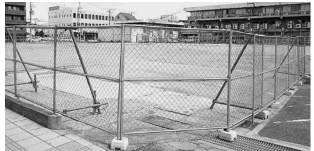
▲北庁舎解体後、整地された新庁舎建設予定地
