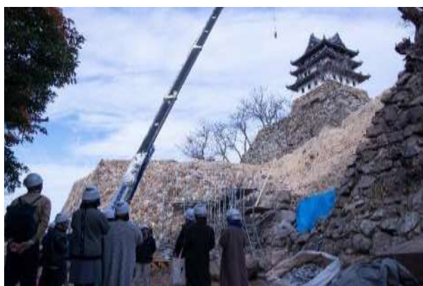
洲本城と修復現場
