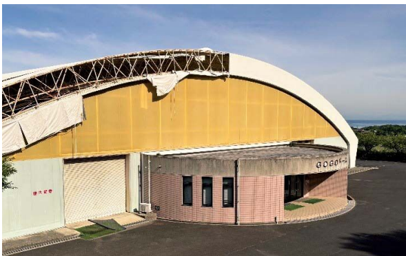
▲解体されるGOGOドーム
