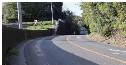
▲路肩のカラー舗装の要望箇所（県道46号線 洲本五色線）
