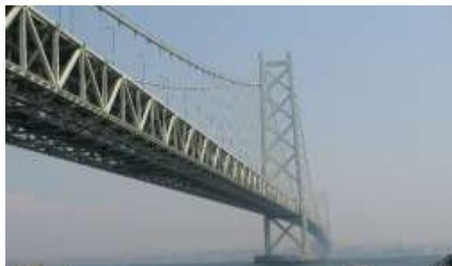
(明石海峡大橋)
