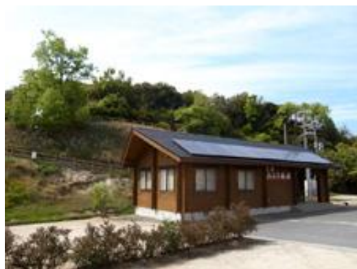
おふさ茶屋 (太陽光発電4kW、小型風力発電、 BDF発電機、EV、蓄電池12kWh、 EV普通充電設備)
