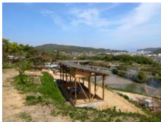
大森谷里山公園休憩所 (太陽光発電4kW、蓄電池3kWh)
