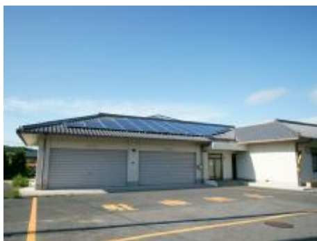
洲本市防災センター鳥飼会館 8.65kW
