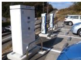
市内の充電設備
