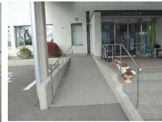
出入口の段差解消 事業費：30万円程度
