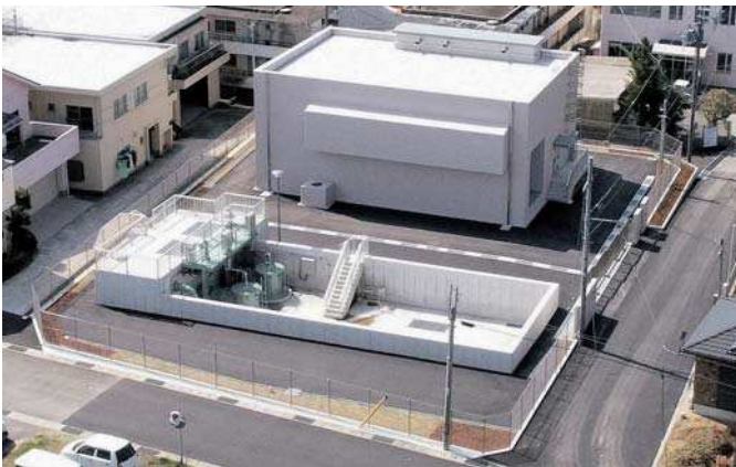
▲内水排除施設（炬口ポンプ場）
