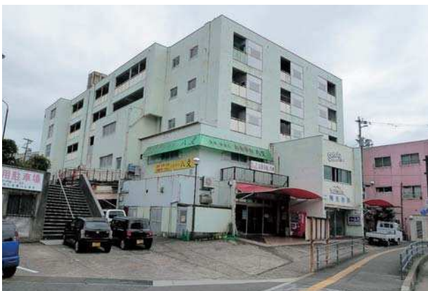
▲近く解体が予定されている、公設市場と市営住宅船場団地
