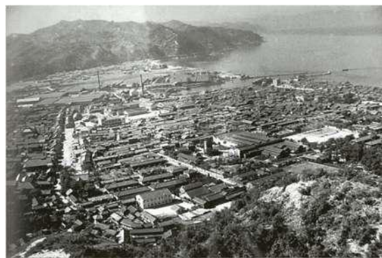
写真 2-2 紡績工場の様子
