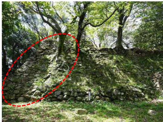
写真② 高石垣の拡幅部
