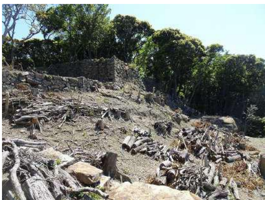
写真 7-18 樹木伐採の様子
