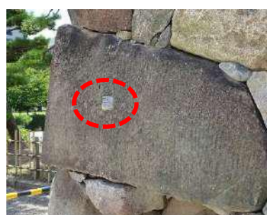
写真 7-4 三次元座標計測用標点の設置 (史跡高松城跡)
