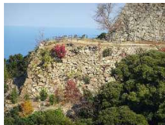
中心部ゾーン北側石垣
