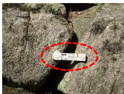
写真 7-2 クラックゲージの設置 (史跡岡崎城跡)
