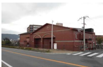
洲浜ポンプ場
