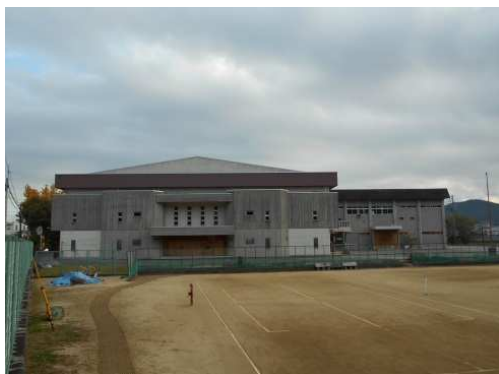
旧スポーツセンター
