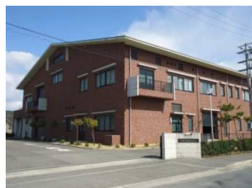
塩屋衛生センターせいすい苑
