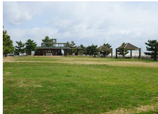
炬口漁港休憩施設
