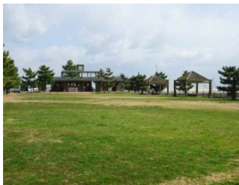
炬口漁港休憩施設
