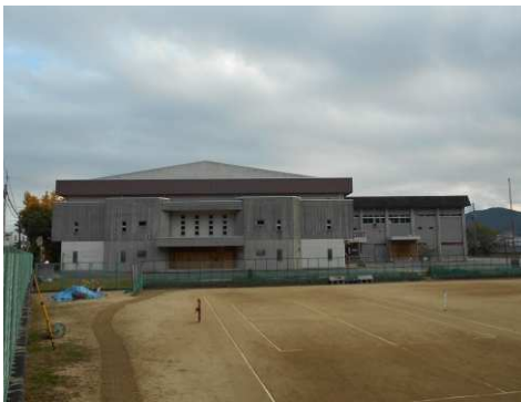
旧スポーツセンター
