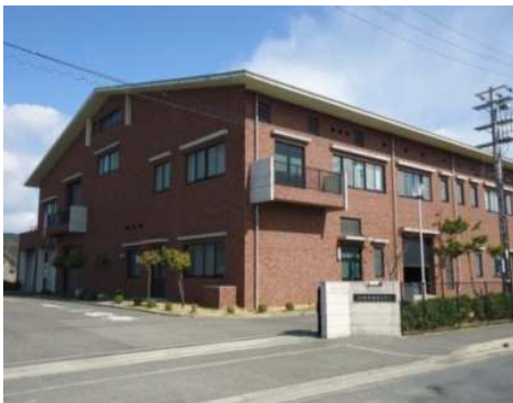
塩屋衛生センターせいすい苑
