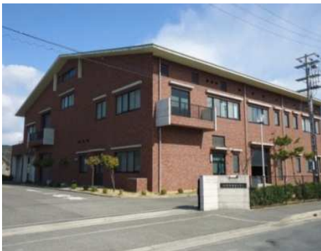
塩屋衛生センターせいすい苑
