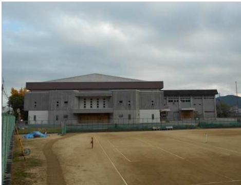
旧スポーツセンター
