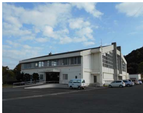
介護予防拠点施設・五色県民健康村 トレーニングセンター
