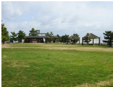
炬口漁港休憩施設
