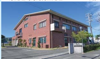
し尿処理場汚泥再生処理センターの改修
