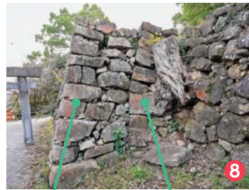
足された部分 元々の石垣
