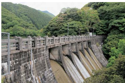
▲上水道用では最初に造られた猪鼻第1ダム
