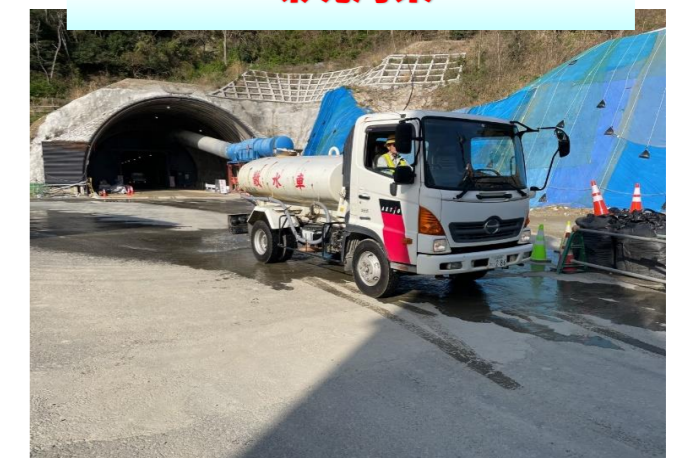
場内散水状況
