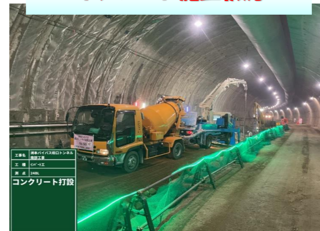
コンクリート打設
