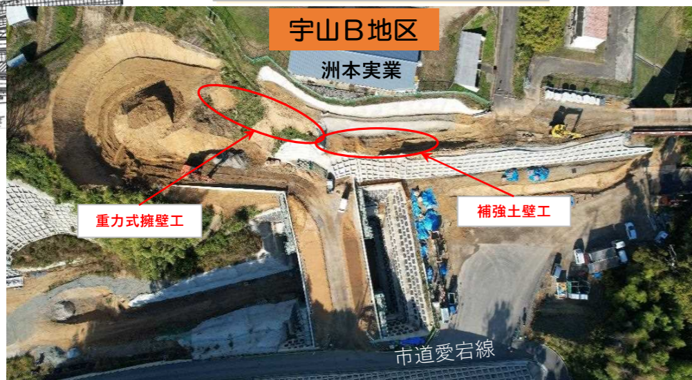
現況写真(撮影日：R5.11.21)
