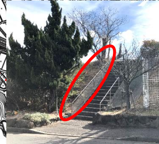
⑥⑦市道 五色町鮎原神 陽 神陽台の階段 【市】手すりをつかめる ように草木を伐採した スピード落とせの注意喚 起看板の設置した
