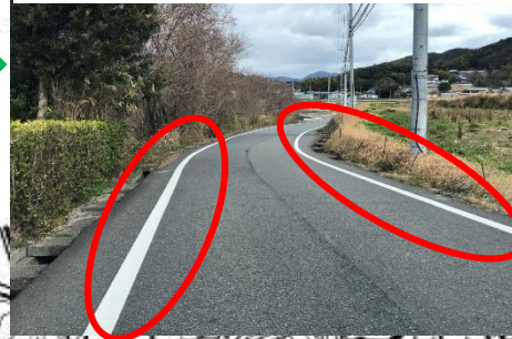
③県道 安乎町宮野原 葭池付近 【県】外側線を引き直した
