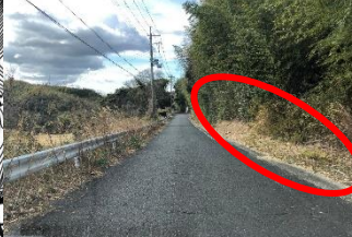
⑪県道 田処～小学校 区間 【県】草木を伐採した
