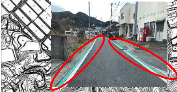
⑧県道 淡路日の出～学童前 【県】外側線とグリーンベルト を引き直した
