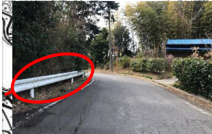
⑤県道 安乎町北谷1144付近の 三叉路 【県】沿道の支障樹木を伐採した 【市】グリーンベルトを塗った
