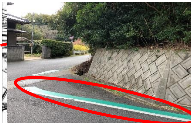
⑧県道 淡路日の出～学童前 【県】外側線とグリーンベルト を引き直した
