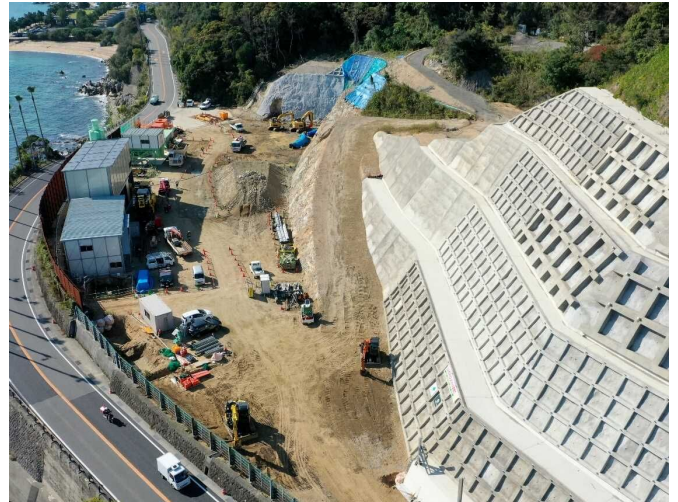
■トンネル工事着手 (令和2年11月 撮影)
