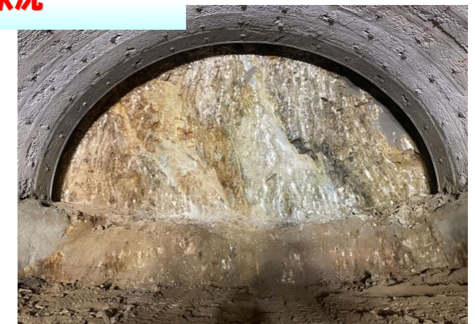
トンネル切羽状況
