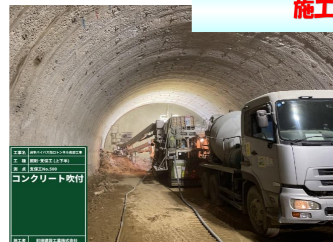
吹付コンクリート
