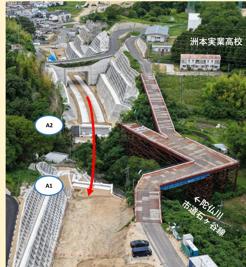
A2橋台付近 仮設工（ヤード整備完了）
