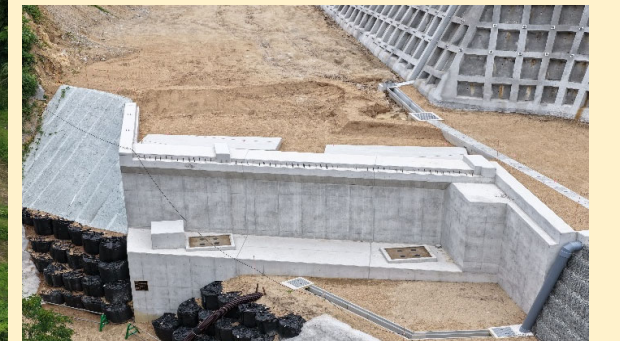
A1橋台付近 仮設工（ヤード整備完了）
