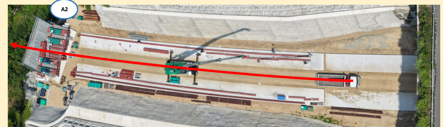
A2橋台背面 仮設工 (ヤード整備完了)
