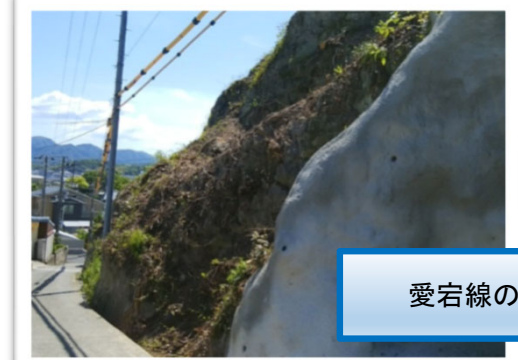
伐採後の土砂流出防止対策として大型土のうを設置しました。
