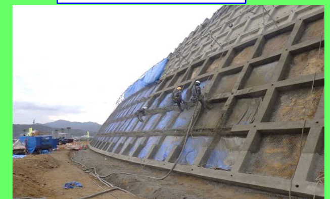
第2法面 吹付砕施工状況
