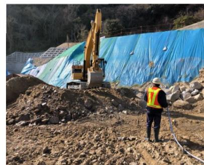
残土処理工(防塵、飛散対策) 散水状況
