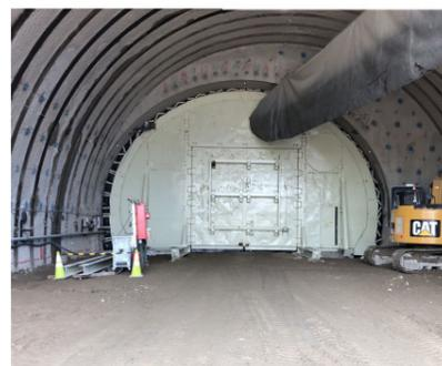
仮設備工(防音、飛石対策) 防音扉設置
