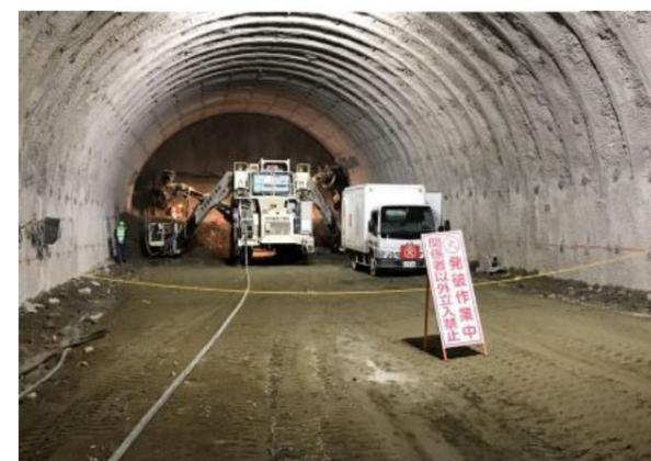
トンネル掘削(発破掘削) 状況
