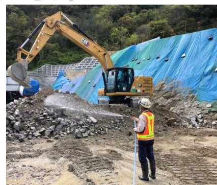
残土処理工(防塵、飛散対策) 散水状況
