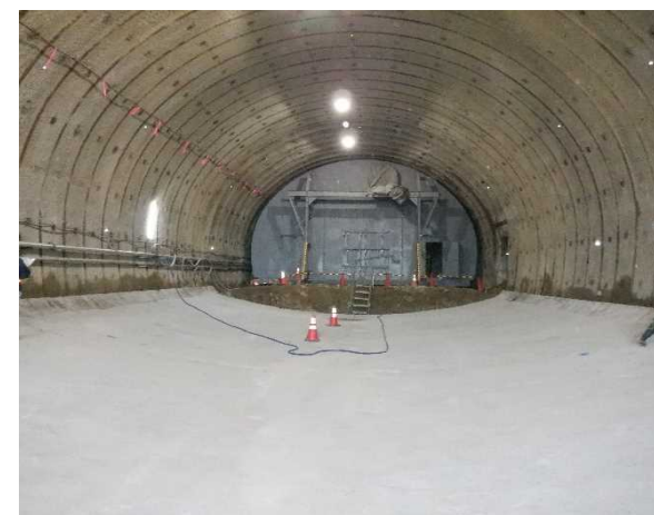
起点側(インバート工)完了
