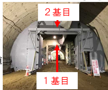
仮設備工(防音、飛石対策) 防音扉設置
