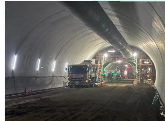
トンネル坑内 覆工打設状況
