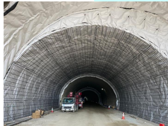
②トンネル坑内 覆工アーチ鉄筋組立状況
