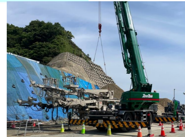
③トンネル機械解体状況
