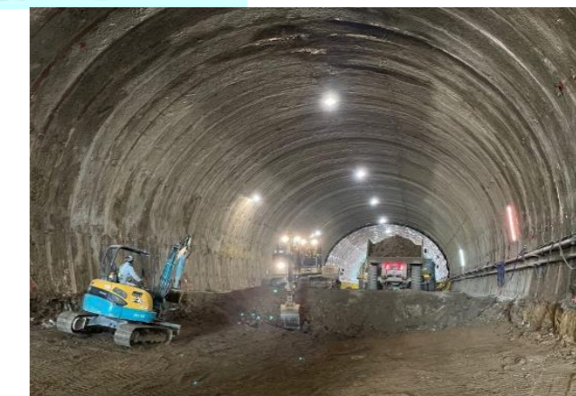
インバート掘削状況
