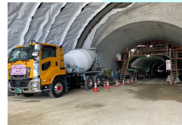
覆工コンクリート打設状況
